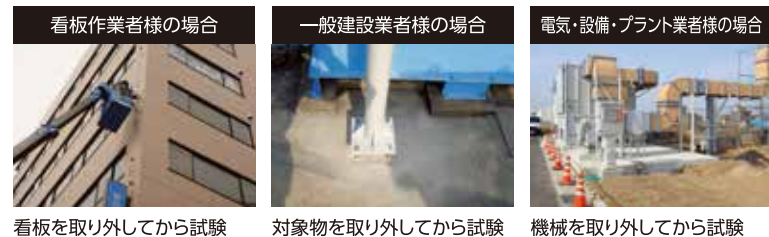
看板を取り外してから試験 対象物を取り外してから試験 機械を取り外してから試験
