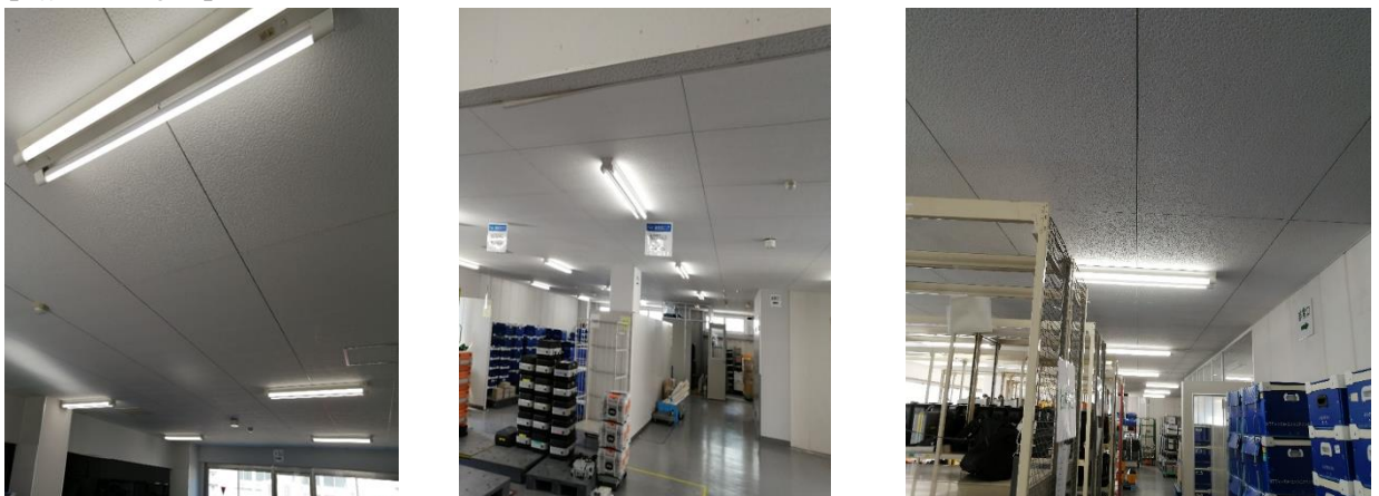
【3階LED工事後】
