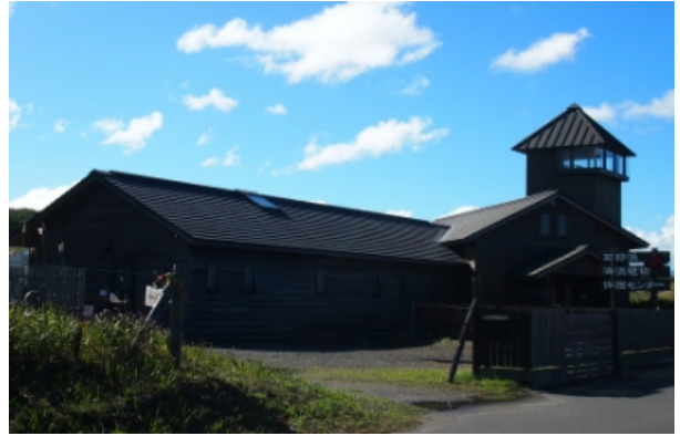
石狩浜海浜植物保護センター
